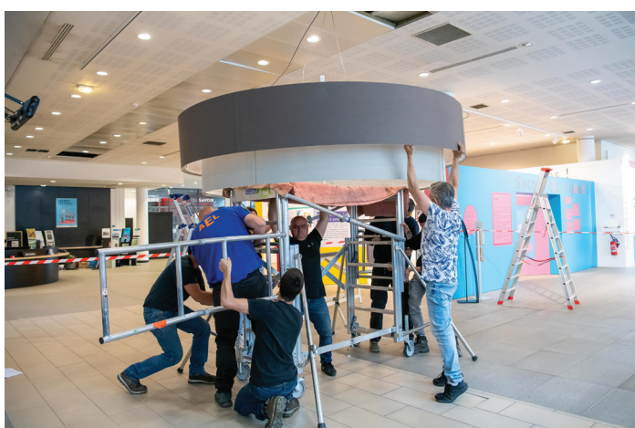
Pose du nouveau lustre dans le hall ©Ville de Limoges
