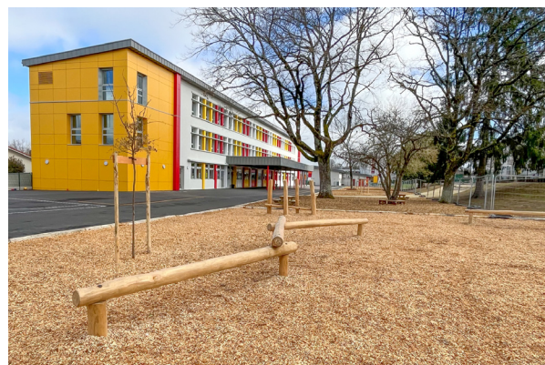
Désimperméabilisation de la cours d'école Condocet-Roussillon
