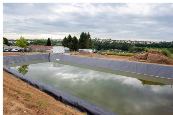
Bassin de récupération d'eau aux serres de la Vergne
