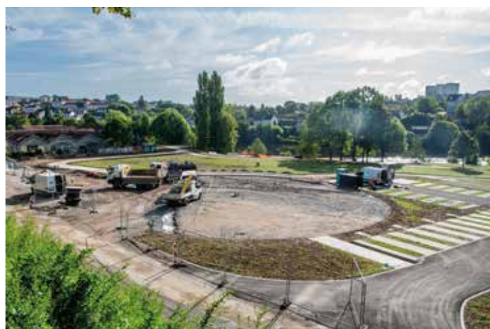
Ci-dessus, les travaux de la Grande prairie.
