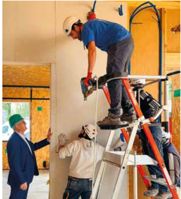
Le maire de Limoges visite le chantier en cours de l'accueil de loisirs qui ouvrira ses portes à Uzurat en 2025 - article page 16
