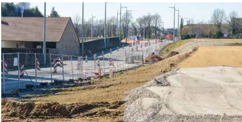
Sur la route du Palais, à la sortie de Limoges, les travaux se poursuivent. Parmi les commerces et enseignes à s'implanter : Grand frais
