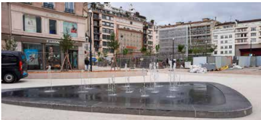
Place fourmier, la fontaine sèche dispose d'une machinerie automatisée
